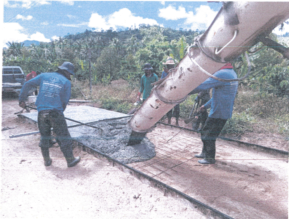
ภาพถ่ายการดำเนินการโครงการก่อสร้างถนนในพื้นที่ตำบลครน ปังบประมาณ พ.ศ.๒๕๖๗
