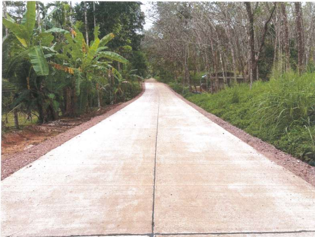
ภาพถ่ายโครงการก่อสร้างถนนคอนกรีตเสริมเหล็ก สายเสริมสุข - อินทนิล หมู่ที่ ๘
