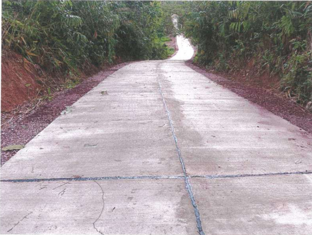
ภาพถ่ายโครงการก่อสร้างถนนคอนกรีตเสริมเหล็ก สายเขาหลักใน หมู่ที่ ๗
