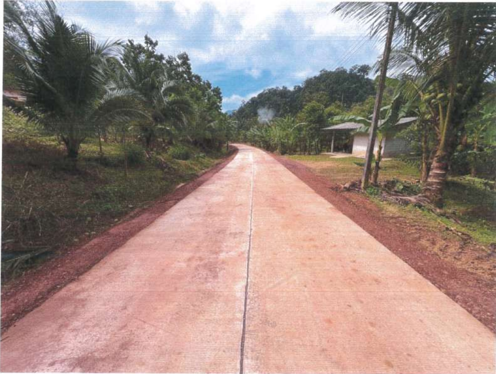
ภาพถ่ายโครงการก่อสร้างถนนคอนกรีตเสริมเหล็ก สายควนลูกเขือ หมู่ที่ ๑๑
