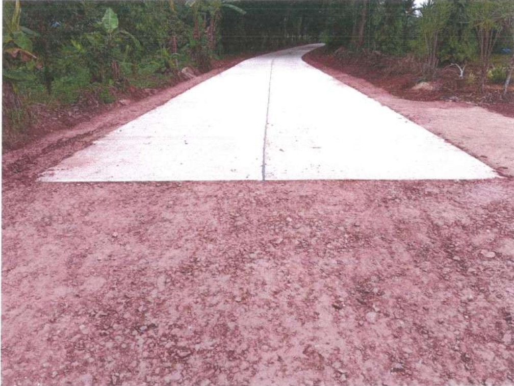
ภาพถ่ายโครงการก่อสร้างถนนคอนกรีตเสริมเหล็ก สายขวัญเมือง หมู่ที่ ๔
