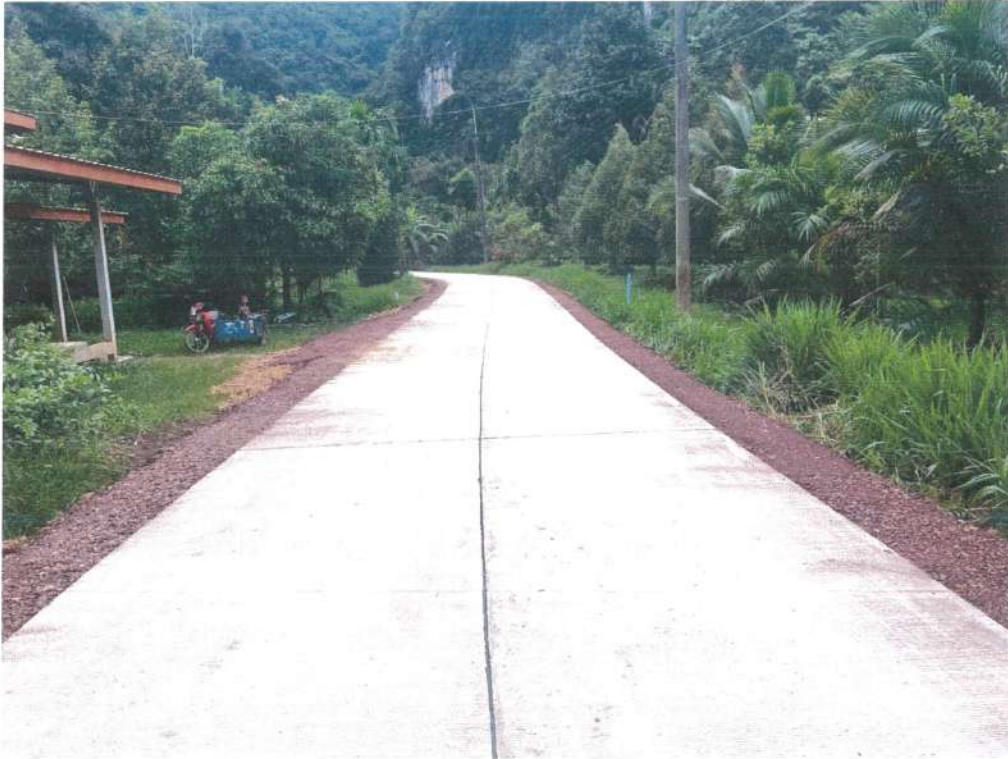
ภาพถ่ายโครงการก่อสร้างถนนคอนกรีตเสริมเหล็ก สายมหารัตน์ หมู่ที่ ๑๔
