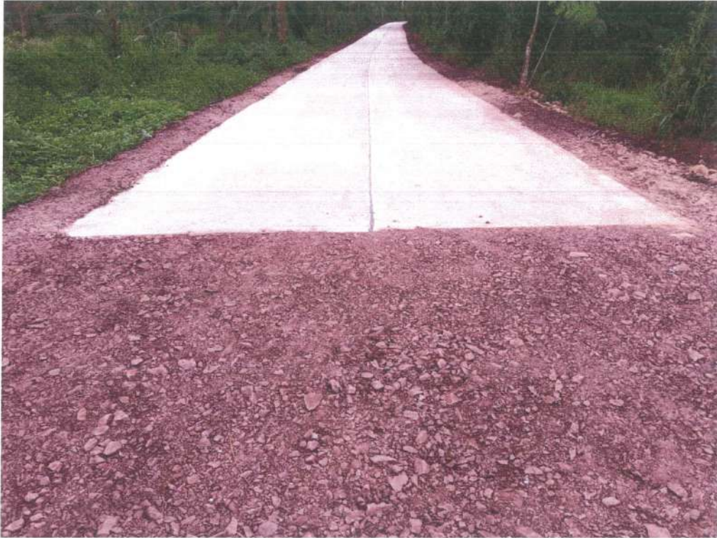
ภาพถ่ายโครงการก่อสร้างถนนคอนกรีตเสริมเหล็ก สายทองแท้ หมู่ที่ ๔
