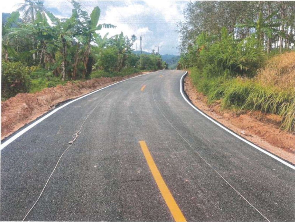
ภาพถ่ายโครงการก่อสร้างถนนแอสฟัลท์คอนกรีต สายตะแบกกล้วย - ปลายกริม หมู่ที่ ๑๐
